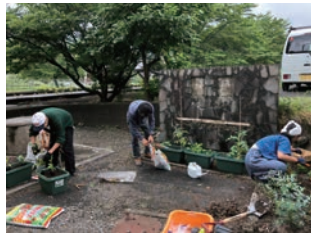
▲プランター設置作業の様子
