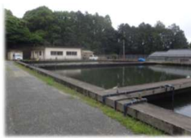
◆ 浦松浄水場の老朽化状況
