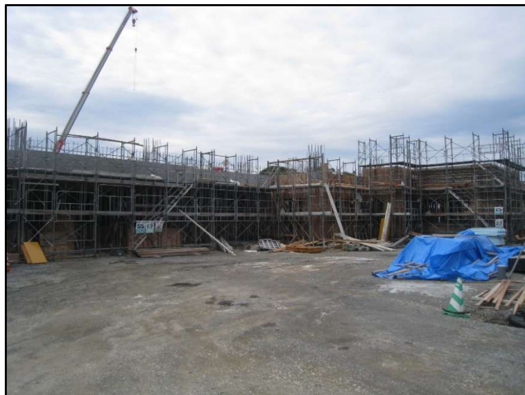
▲校舎棟1階部分の外壁が現れてきました
