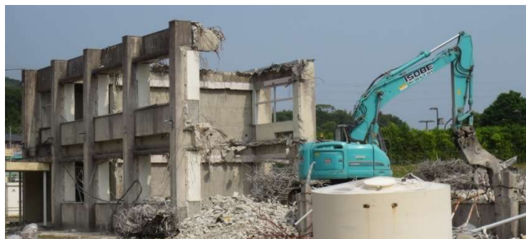
▲ 解体が進む旧勾金中学校校舎
