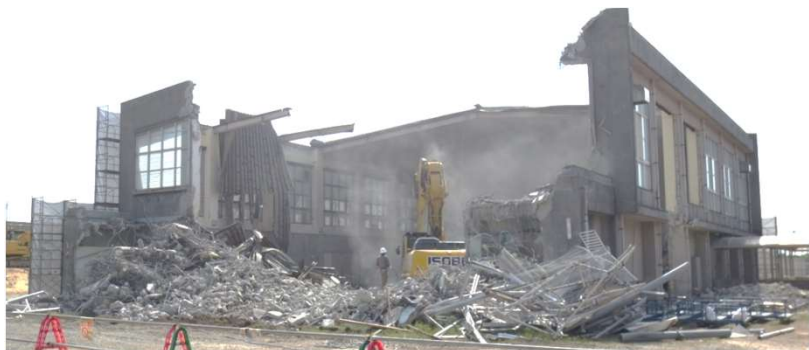
▲解体が進む旧勾金中学校体育館
