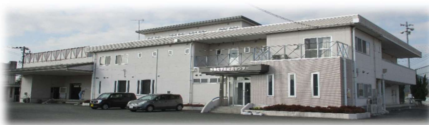
▲学校給食センター全景
