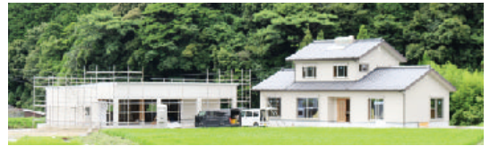
建築が進む住宅
