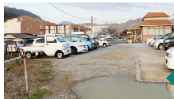
整備前の香春駅駐車場
