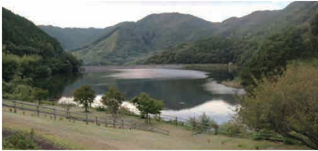
溪流公園がある呉ダム
