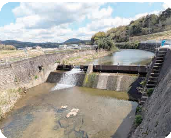
改修が完了した前田井堰
