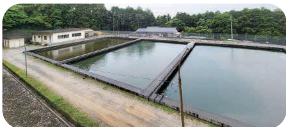
更新を進める浦松浄水場
