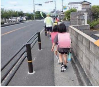
ガードパイプ設置後
