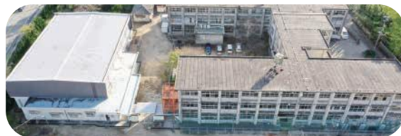
解体予定の旧香春中学校
