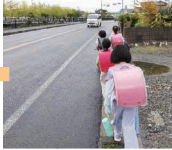
ガードパイプ設置前
