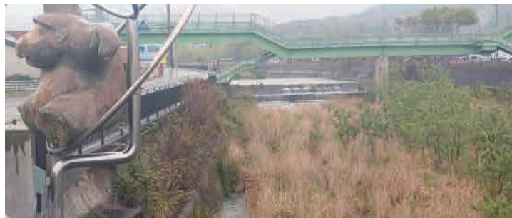
土砂が堆積し、樹木が密生している松本井堰
