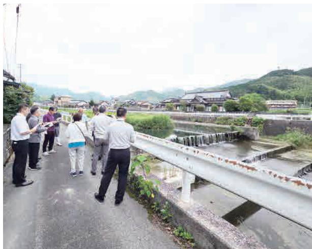
改修工事予定の藪田井堰
