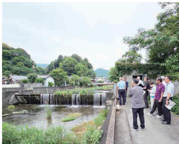
改修が完了した松ノ木河原井堰
