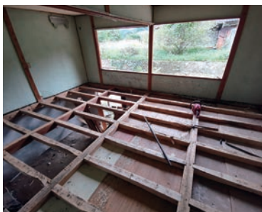
▲解体過程では家の構造を直に見る良い機会になった
